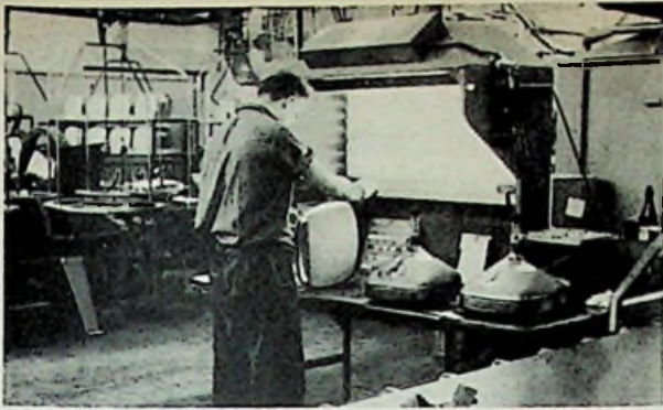
Äußere Endkontrolle der Bildröhre
